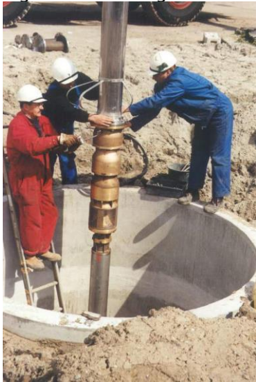
Figuur 4.1 Aanleg van een bron van een open bodemenergiesysteem.
